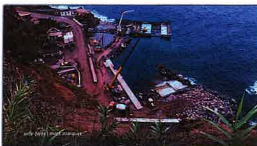
Fig 7B: Porto do Topo na fase final das obras
