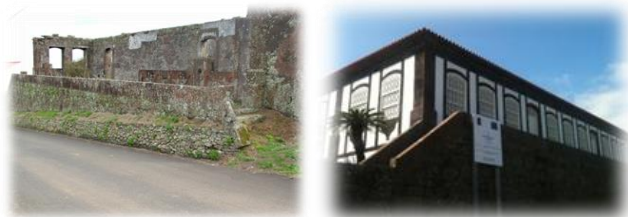
Fig12: Ruínas do Solar dos Tiagos e edifício restaurado.
